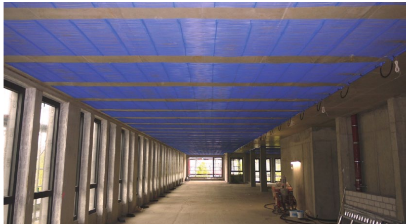
Im Vergleich: Aufbau eines Nass- und Trockensystems, oben auf Putz an einer Rohbetondecke, unten eine noch offene Trockenbaudecke mit aufgelegten Kapillarrohmatten (Abb. Clina)
