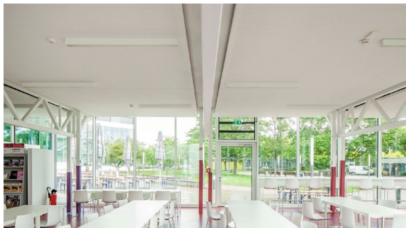
Unsichtbar und funktional, selbst bei stark verglasten Außenflächen. Moderne Heiz- und Kühlflächensysteme können hohe Wärmelasten abführen und durch Strahlung für eine behagliche Raumwärme sorgen (Abb. Zehnder)
