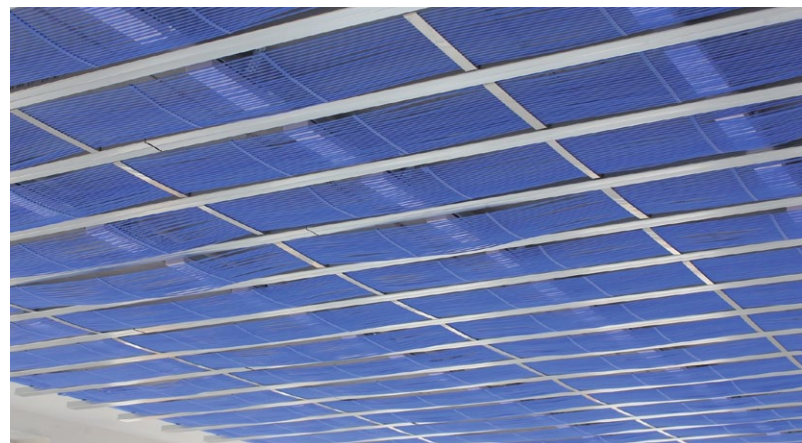
Im Vergleich: Aufbau eines Nass- und Trockensystems, oben auf Putz an einer Rohbetondecke, unten eine noch offene Trockenbaudecke mit aufgelegten Kapillarrohmatten (Abb. Clina)
